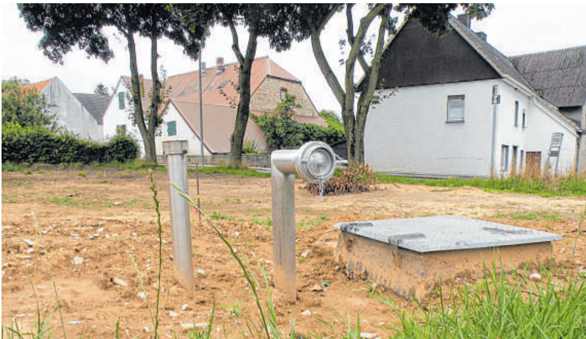
Es soll endlich los gehen mit den Bauarbeiten für die Netzwerkstatt: Das wünschen sich die Westereider; bislang ist nur der Anschluss des Löschwassertanks sichtbar.
