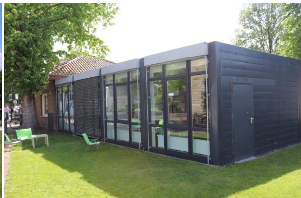
Temporärer Anbau Kindergarten
