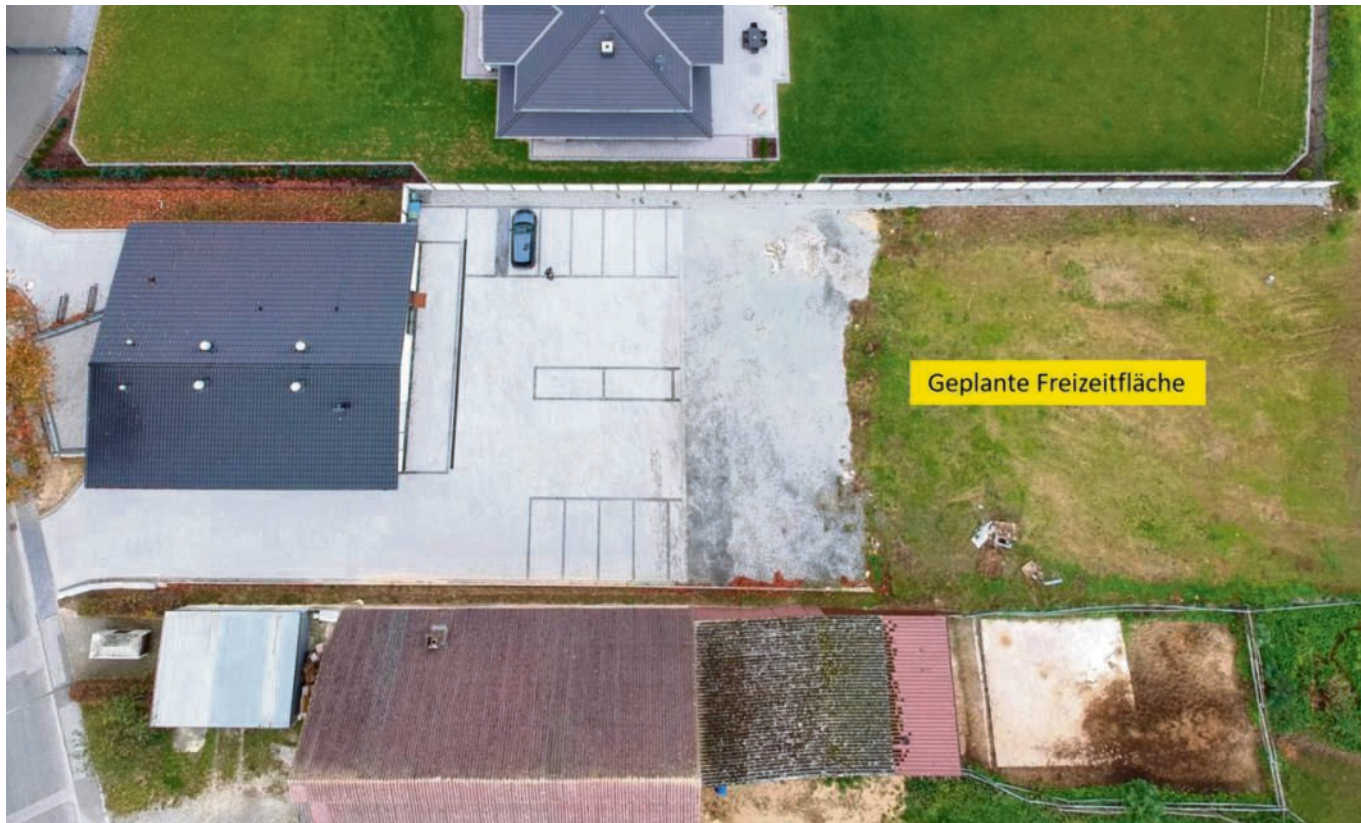
Auf der brachliegenden Fläche hinter der Netzwerkstatt (l.) soll die Freizeitfläche entstehen. Zunächst wird aber noch der Parkplatz um ein paar Meter erweitert.
