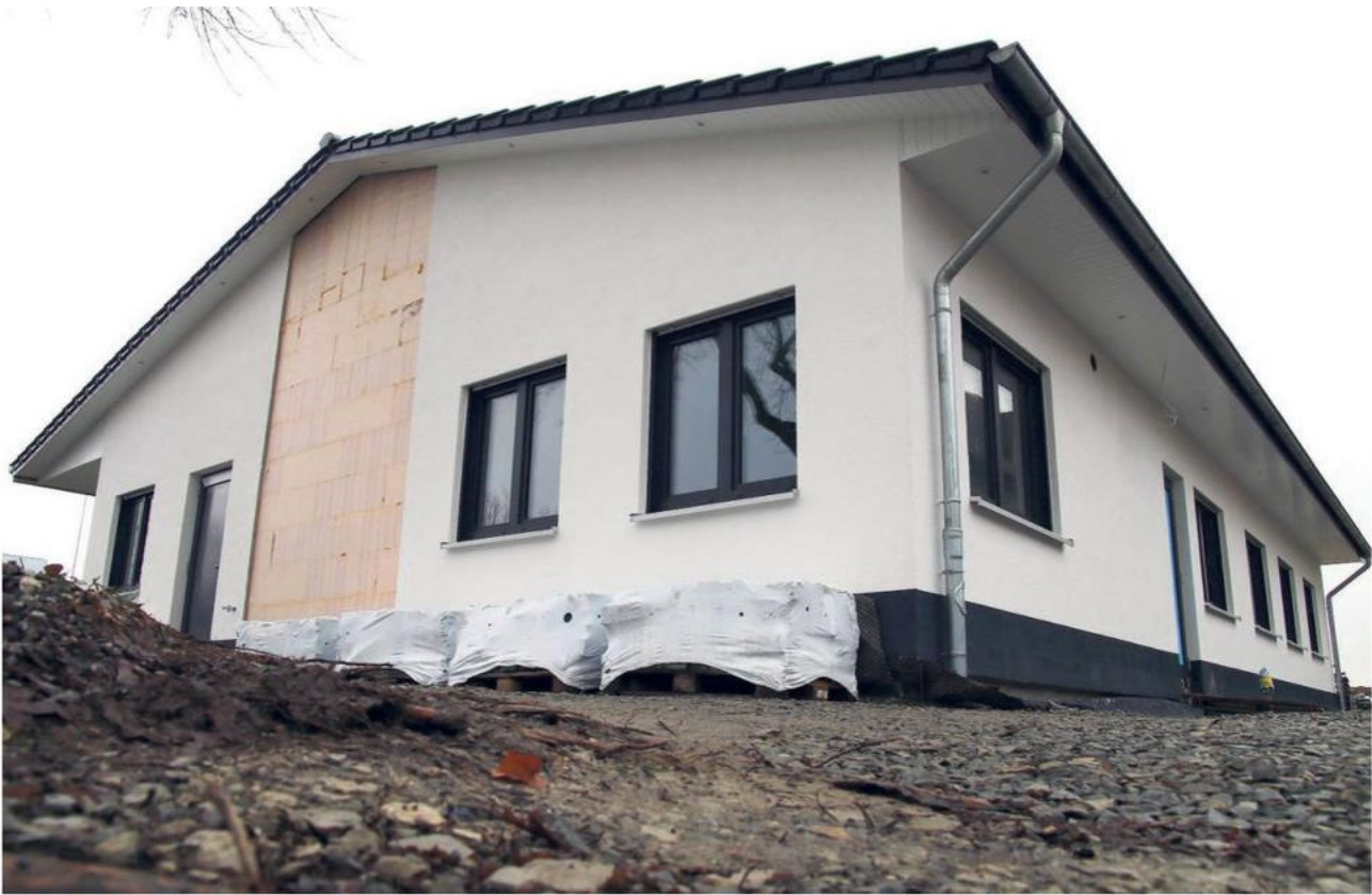
An der Dorfstraße nimmt sie immer mehr Form an: Die Netzwerkstatt, die noch eine schöne Bruchsteinwand bekommen soll.
