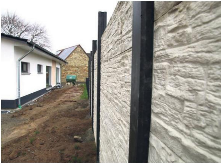
Ende November ist bereits ein stabiler Grenzzaun entstanden.
